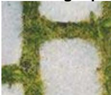
Rasenfugenpflaster wird aus Pflastersteinen mit 1-2 cm breiten Fugen verlegt. Die Fugen werden mit Muttererde verfüllt und mit Rasen eingesät. Verwendet werden die Pflaster für Gehwege, Stellflächen, Parkplätze und stärker frequentierte Fahrwege.
