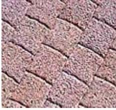
Porenpflaster bestehen aus großporigen, wasser- und luftdurchlässigen Betonsteinen. Geeignet sind die Pflaster für Fußwege, Zufahrten oder Stellplätze.
