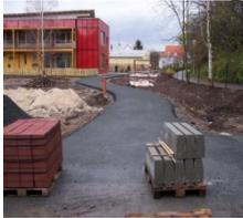
Hier besteht die Oberfläche aus einer Beton- oder Asphaltbetondecke mit einem frostsicheren Unterbau aus einem Mineral- oder Schottergemisch. Pflasterflächen mit einer dichten Fuge sind ebenfalls mit einem frostsicheren Unterbau aus einem Mineral- oder Schottergemisch ausgebildet.
