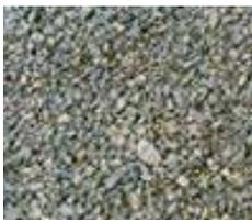
Hier besteht die Oberfläche aus Kies und Splitt mit einer mittleren Körnung. Aufgebracht werden Kies- und Splittdecken auf einem durchlässigen Unterbau.
