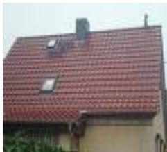
Hier besteht die Oberfläche infolge der Anforderung an die Dichtigkeit aus einem geschlossenen Gefüge der Baustoffe. Diese können beispielhaft Materialien aus Beton- oder Tondachsteinen, Dachziegel, Schiefersteine, Blechdacheindeckungen oder Bitumen- und Polymerbahnen sein.
