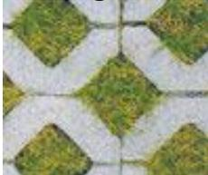
Diese Betonsteine besitzen rechteckige oder wabenförmige Öffnungen, die mit Mutterboden befüllt und mit Gräsern bewachsen sind.
