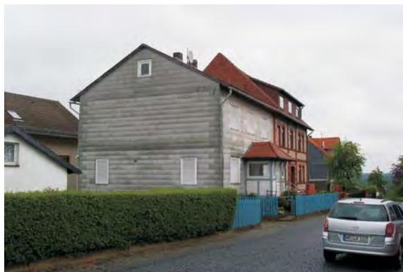
Der Eternit-Behang wurde ersetzt durch eine an historische Vorbilder angelehnte Fassadenbekleidung aus Schiefer. Das Dach wurde mit roten Tonziegeln eingedeckt.
