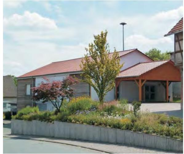
Die Wärmeversorgung über elektrische Nachtspeicheröfen genügte schon lange Jahre nicht mehr den Mindestanforderungen. Der behutsame Umbau samt einer energetischen Überarbeitung der Fassade und des Daches sowie die Erneuerung aller Fenster und Türen schafft heute neben der Energieeinsparung auch eine wesentliche Verbesserung der räumlichen Atmosphäre.
