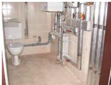
Haustechnik erneuert. Hierzu zählen Küche, Kühlraum, Gaszentralheizung und eine Überarbeitung der Toiletten samt den Leitungsführungen. Die Beleuchtung im Hochparterre (Saal und Nebenräume) wurde vollständig und im Parterre größtenteils erneuert. Die Außenfassade wurde durchgehend mit Mineralwolle gedämmt. Die Wände wurden danach teilweise verputzt, teils erhielten sie eine Bekleidung aus einer Lärche Stülp- Schalung.
