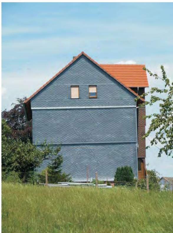
Bei dieser sehr dauerhaften Sanierung der Fassade wurde die Möglichkeit einer Dämmung des Giebels gleich mit genutzt. Oftmals werden große Flächen von Altbauten mit einem Behang ver-
