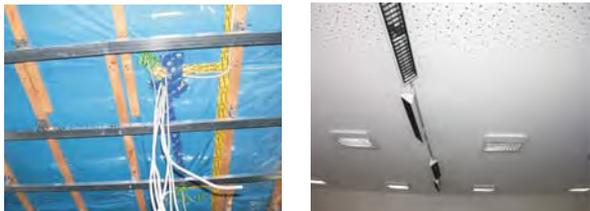
ist die sehr arbeitsintensive gelochte Akustikdecke. Aus Gründen des Brandschutzes wurde unter der nackten Konstruktion des Binderdaches zunächst die feuerhemmende F 30-Decke ausgeführt, um anschließend die sichtbare Akustikdecke darunter auszurichten und zu montieren. Diese Präzisionsarbeit versteckt heute den erforderlichen komplexen Schichten- aufbau dieses Bauteils.
