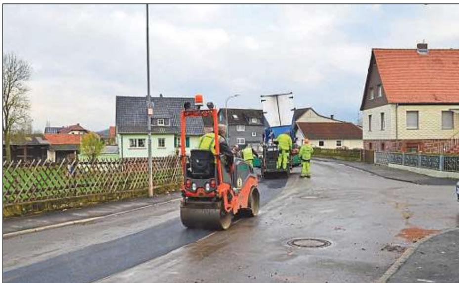
Die Bauarbeiten zum Nahwärmenetz Kleinseelheim schreiten voran. Im Sandweg wird der nach Verlegung von Nahwärme- und Glasfaserleitungen geschlossene Graben asphaltiert. Foto:Waldhardt
